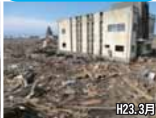
藤曾根排水機場
