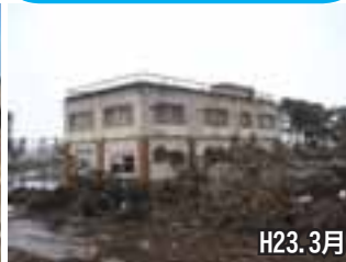
寺野排水機場
