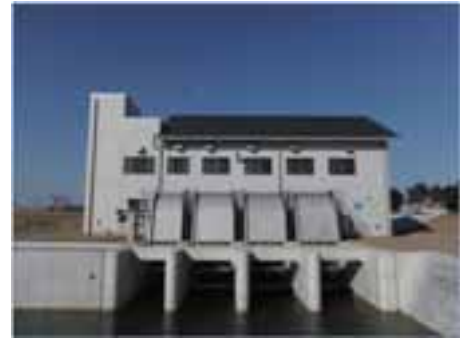
藤曽根排水機場(外観)
