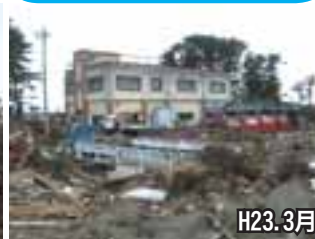
閑上排水機場
