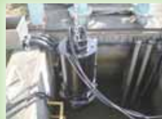
新ポンプ設置状況
