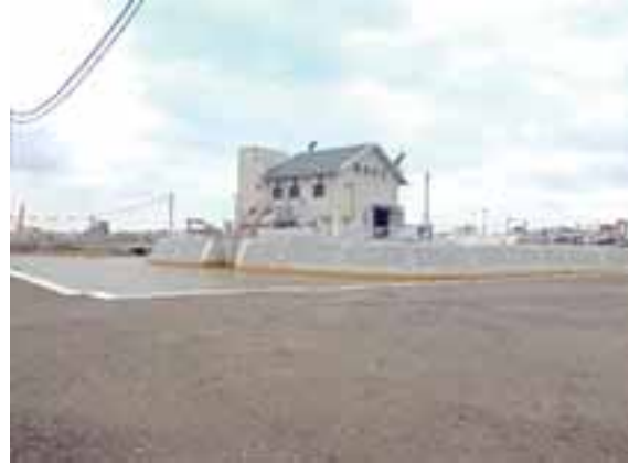
三軒茶屋排水機場（平成28年度完成予定）
