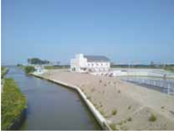
寺野排水機場（木流堀排水路）
