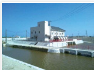
① 相の釜排水機場
