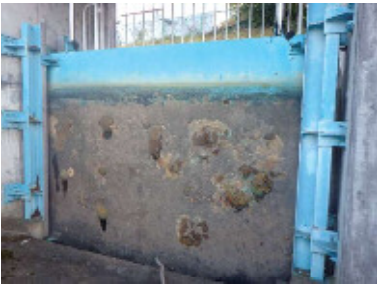
取水ゲートの塗装劣化
