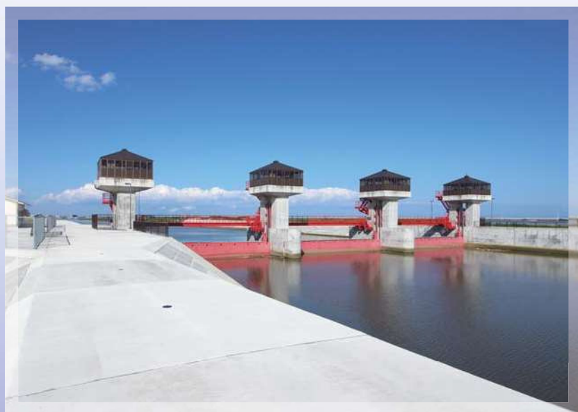
H29.3 完成 貞山堀防潮水門
