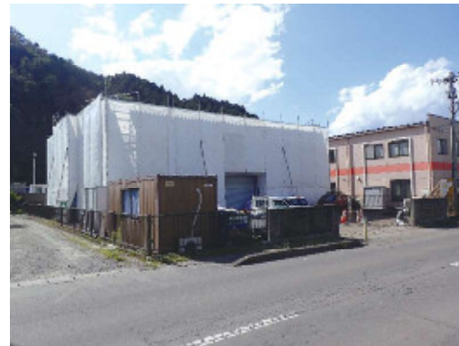
予備ゲート格納庫
