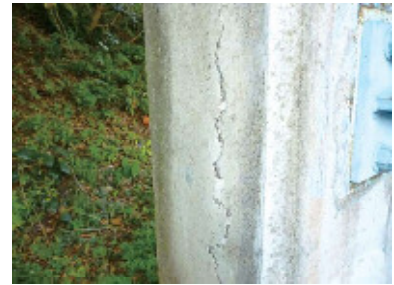
右岸（川裏）門柱のひび割れ
