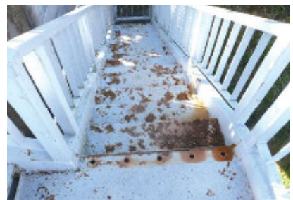
階段の腐食
