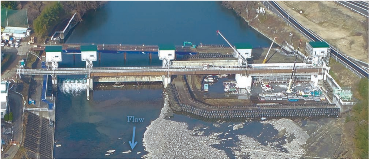
(※仮栈橋・仮締切設置後の全景 [下流側上空から撮影])
