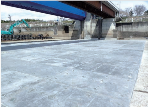
エプロン補修（完了）
