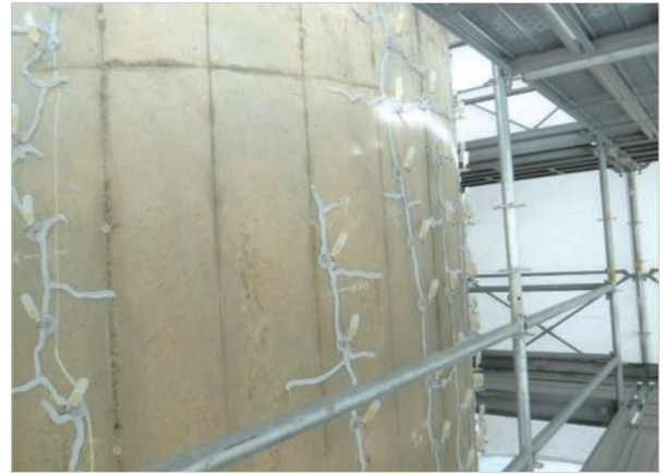
頭首工導流壁の断面修復
