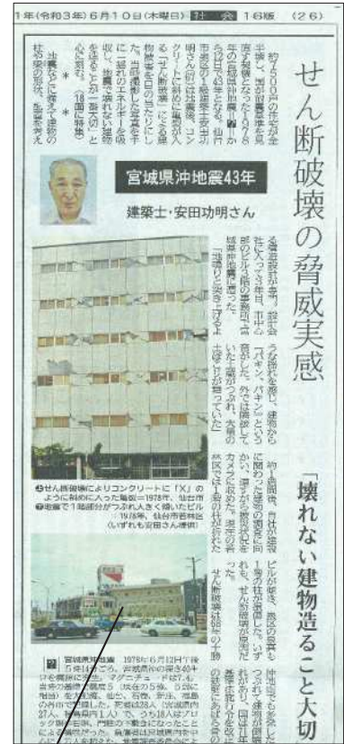
1階がつぶれたビル（仙台市内）
