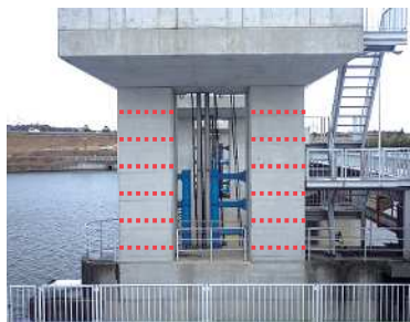
鉄筋補強をしたコンクリート柱 (赤点線に鉄筋を挿入した)
