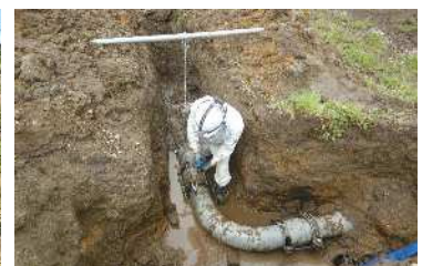
復旧状況（名取市関上地内）
