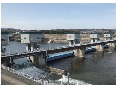
完成した名取川頭首工
