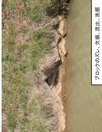
水路護岸欠損、流出、洗掘
