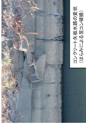
コンクリート矢板水路の変状 (はらみによる通水断面の阻害)
